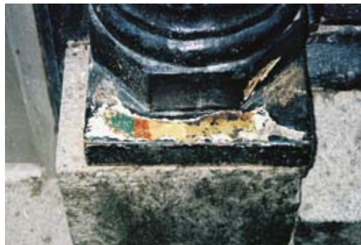
Detalj av gjutjärnskolonn vid Västerlånggatan. Spår av äldre färglager. Foto: Maria Lorentzi.
